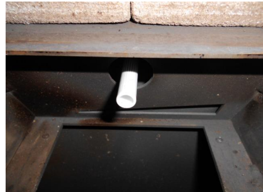
Zündung ist gesteckt und kann herausgezogen werden bzw analog wieder montiert werden
