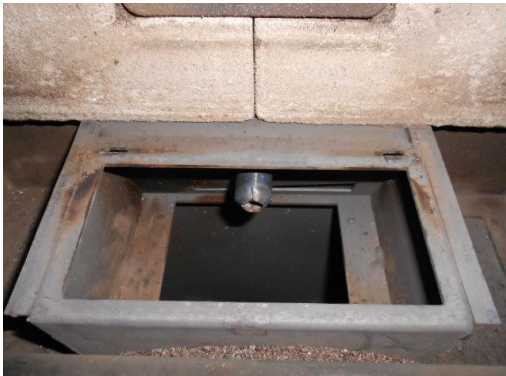
Hülse entnehmen durch Drehung nach links und gleichzeitiges Herausziehen
